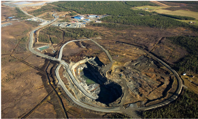
Figure 60: Suurikuusikko (Kittilä) mine in 2007 – the circular road indicates the final extent of the open pit
